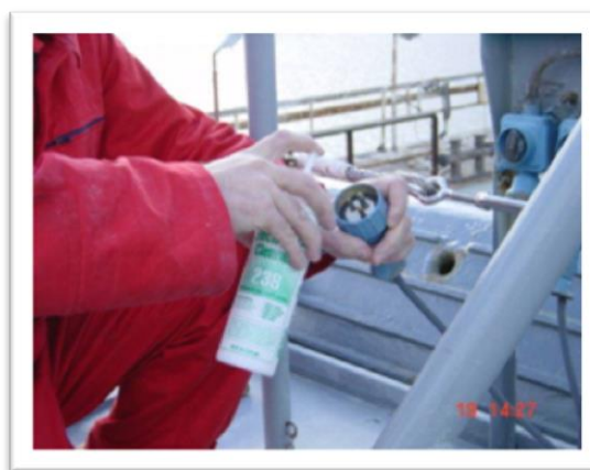
Slika 4.6 Primjena inhibitora za zaštitu električnih kontakata [8]
