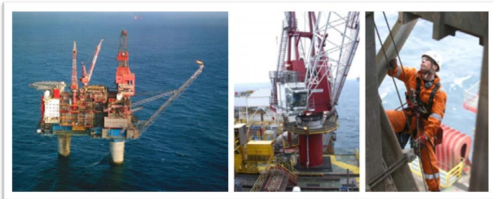
Slika 9.1 Platforma za vađenje nafte "Gullfaks B" [8]
